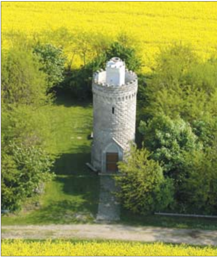
Mitten im Raps: Der Bismarckturm in Oberg.
