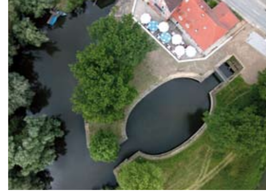
Palmschleuse bei Lauenburg
